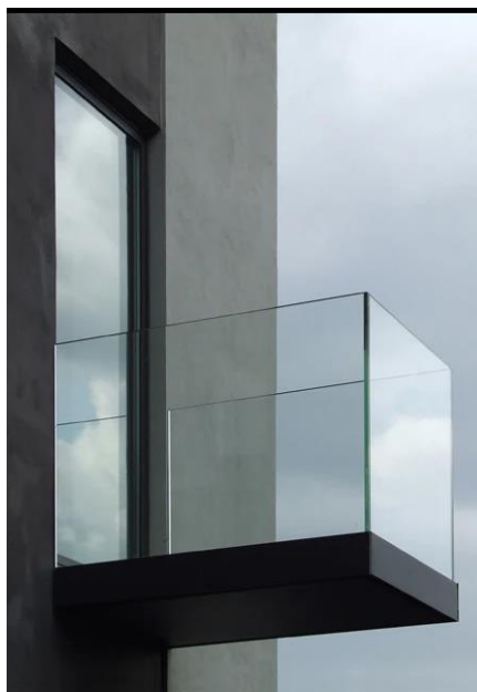
Przykład szklanej balustrady zewnętrznej – na tarasie – zielony dach
