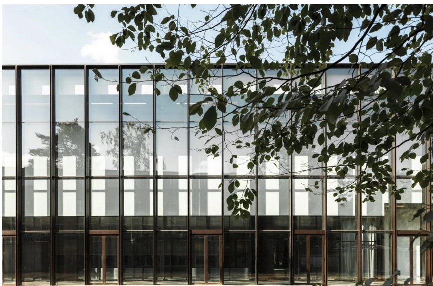
Przykład szklanej ściany kurtynowej
