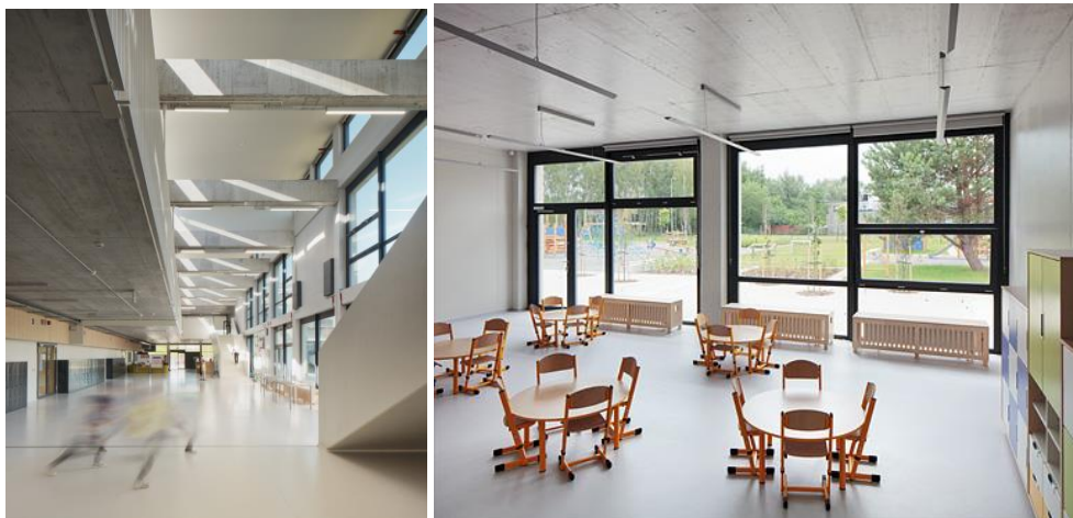
Przykład odsłoniętego stropu i podwieszonych instalacji
