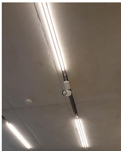
Przykład odsłoniętego stropu i oświetlenia w stropie
